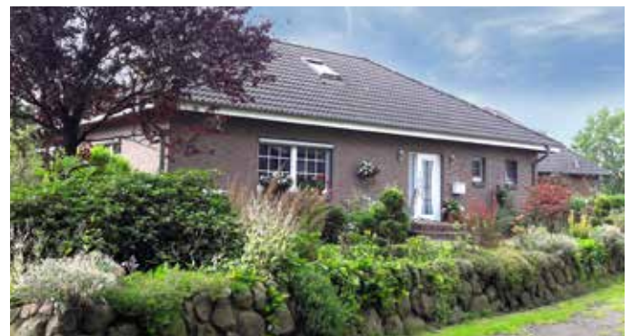
In einem der Eigenheime wurde ein Teil der Garage zur Heizzentrale umgebaut.
